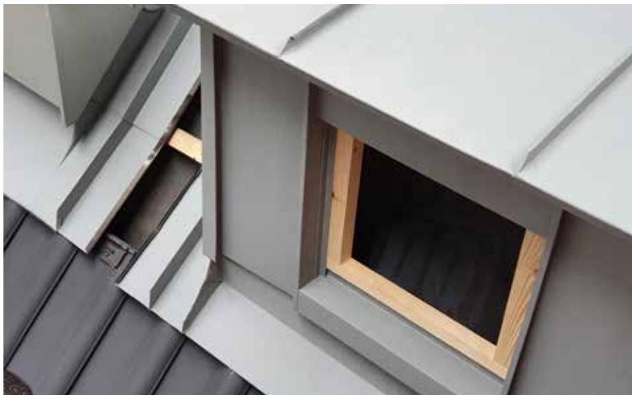
Gaubenfront und -eindeckung in Stehfalz-Ausführung
