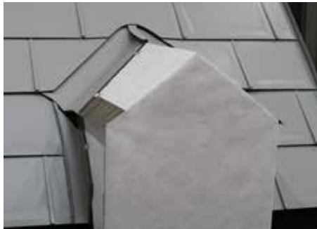
Dachplatte R.16 Kehle, seitlicher Wandanschluss
