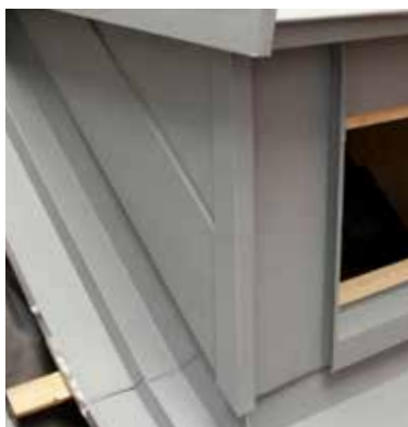
Gaubenbekleidung mit Sidings
