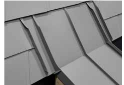
Dachschildel DS.19 Anschluss an Stehfalz
